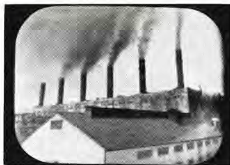
図 3.17 関西電力尼崎第一火力発電所における排煙監視 実験時の受像画面（天候薄曇）
