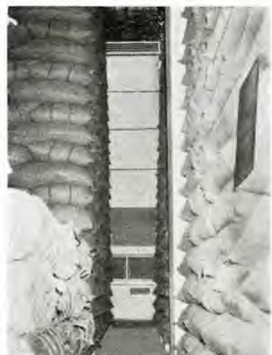
図 5.3 鈴与倉庫におけるすえ付写真 Fig. 5.3 Installation of the device in the granary.
