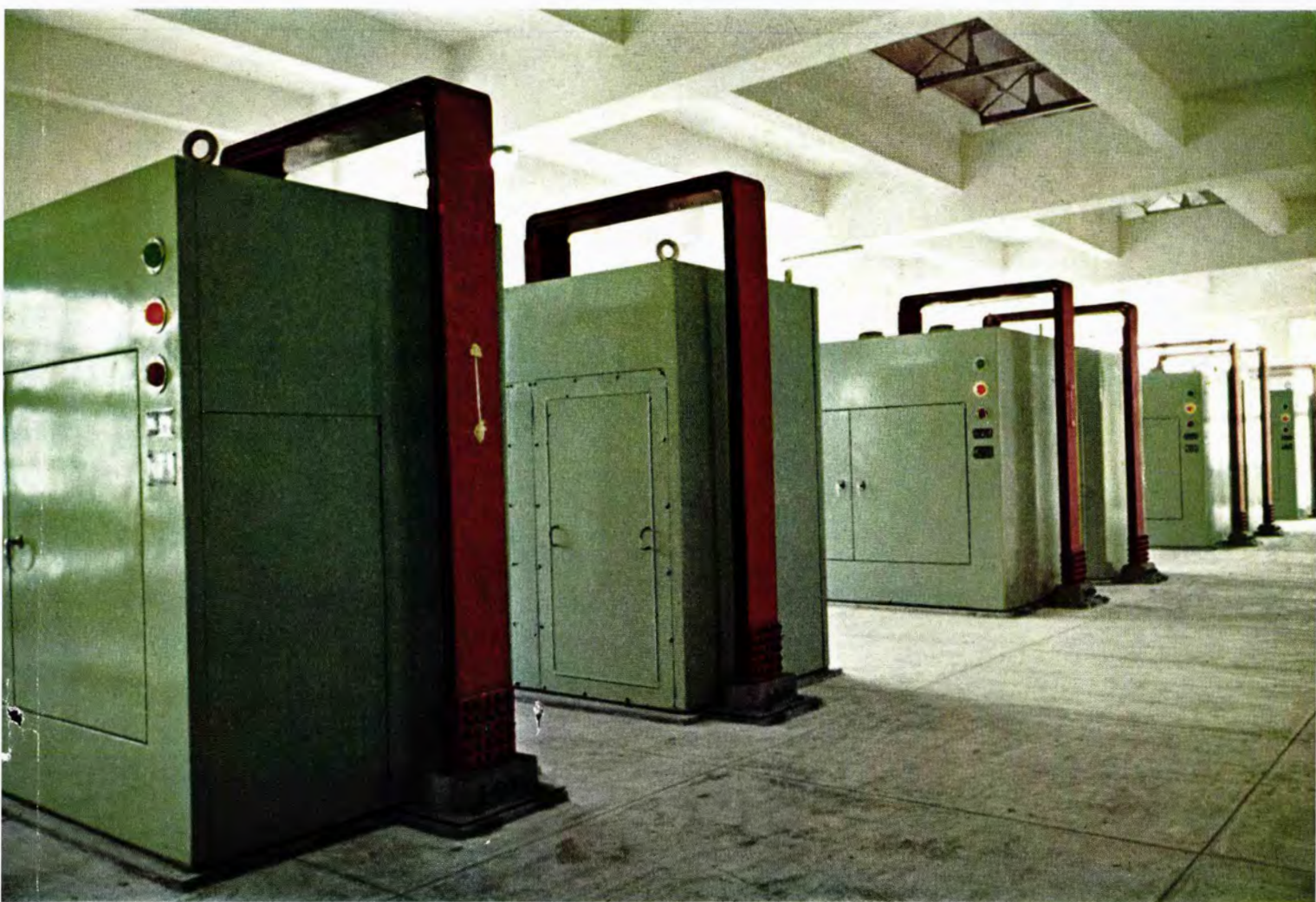
わが国最大の食塩電解用 82 V 120,000 A シリコン 整流器 (徳山曹達納め)
