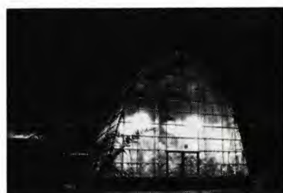
⑪ 九州大学 熱帯植物温室 HF-200T ヒダ付ガラスグローブ器具4セット光源高さ4m, 平均照度300lx。
