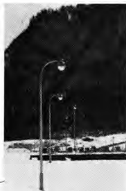
③7 中部電力新太田切水力発電所 (長野) 屋外変電所および放水路の照明 HF-400T×1 灯用透明ヒダ付ガラスグローブ器具 9 セット ポール柱高さ 5m および 6 m, 構内約 10 lx, 放水路約 5 lx.
