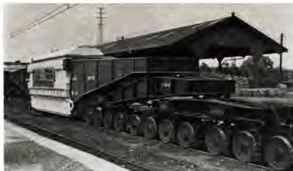
シキ-400B 1 形大物車による 120 MVA 変圧器の輸送姿 View of 120 MVA transformer transportation by SHI-KI 400B 1 special waggon.
