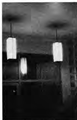
③ 吉原市民会館（吉原市）1 階階段室ホール上の FL-20×4 灯用硬質塩化ビニルカバー付パイプつり下器具 3 セット シェブールな立派なデザインでおもしろい 床上約 100 lx.
