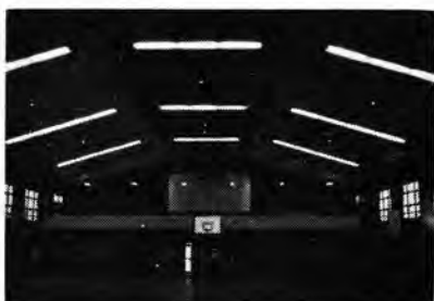
⑮ 西ノ宮高校(西宮)室内体育館 FL-40W×2灯用保護ガード付埋込器具。
