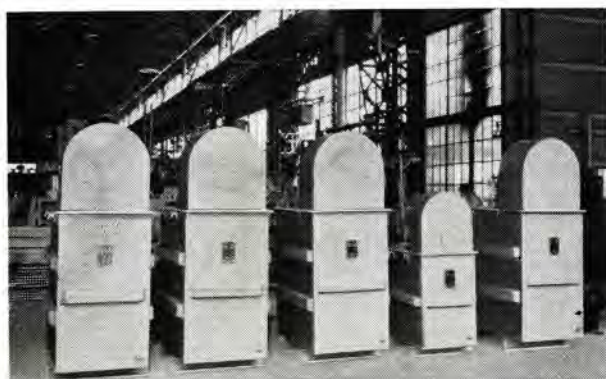
単器形 コンデンサ三相 500 kVA 6,600 V 50 c/s KT 形 (小形のものは 200 kVA) 3 Phase 500 kVA 6,600 V 50 c/s tank type capacitor (small capacitor is 200 kVA).
