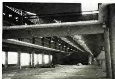
⑮ 釧路市魚市場（釧路）ケイ光水銀灯 HF-200 用防水形器具は両側および下面に投光し回転する器具 (a) とパイプすり反射ガサ付 HF-300×1 灯と白熱電球 150W×2 灯組合せ器具 (b)。
