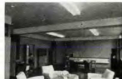
⑥ 市川市庁舎（千葉県）市長室 FL-40 W×2 灯用 2 連器具直付で最近流行の乳白色の総アクリカバー器具、手前の応接室はケイ 光灯の外に白熱電球によるピンホール器具がちりばめである。
