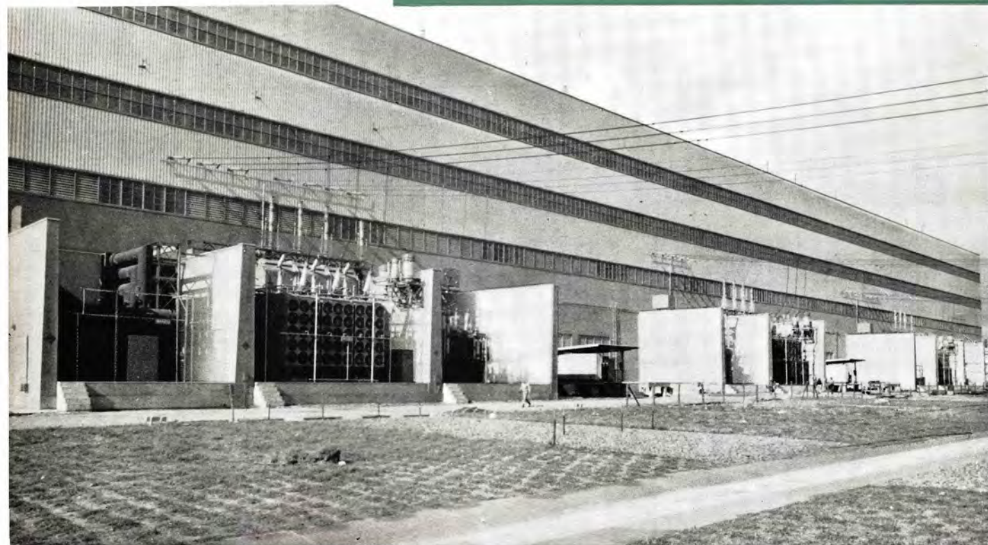
190 MVA 特別三相式送油風冷変圧器
