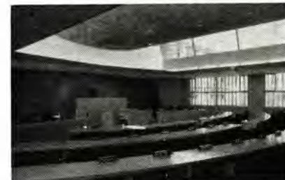
⑧ 同上 議事堂内 天井周囲の間接照明およびピンホール照明、中央の円形器具は FL-40×7+FL-20×2 ハニーフライトルーパ使用。
