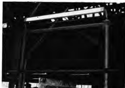
③0 米軍沖縄基地送変電設備工事変電所構内照明用 FLR-110HW×1 灯フラッドライト器具×36 灯-2 本のポールで支えられた反射が器具内に 1 灯ずつ入っている。
