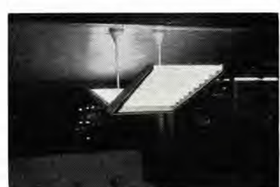
④ 池内ビル（札幌）FL-20×10 灯用シャンデリア風器具 シャンデリアは住々にして形状のおもしろさだけをねらった意匠のものが多くこの設計では意匠のよさのほかに全般照明器具としての機能が十分具備されている
