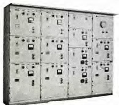
舞鶴造船所、飯野海運 タンカ 鶴邦丸 集合起動盤 Collective starting panel.
