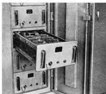
同左用 シリコン 整流器の扉をあけ トレー を引出したところ The tray of the above silicon rectifier drawn out by opening the door.
