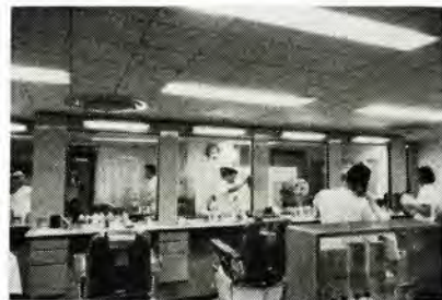
③4 新大手町ビル (東京) 内理髪室 FL-40 W×2 灯および 1 灯用埋込下面開放形器具、FL-20 W×1 灯反射形ミラーブラケット 水平面 1,300～1,800 lx. 鉛直面 500～800 lx (いずれも作業面)。
