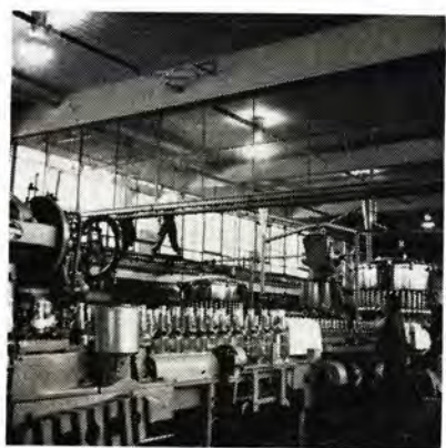
⑯ 合同酒造旭川工場（旭川）ケイ光水銀灯 HF-300 器具で反射ガサは換気をよくするとともに天井面にも光の出る特殊構造のもの、安定器は内蔵している。
