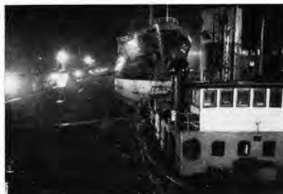
⑩ 三菱造船下関造船所(下関)ドック内部の照明 ドック側壁の埋込形HF-300による照明で船底部で10lx。
