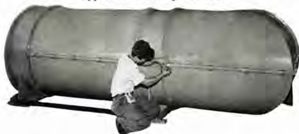
KB 形 離 相 母 線 Type KB isolated phase bus.
