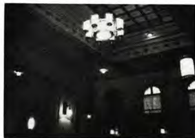
⑭ 福岡県庁議事堂（福岡）水銀灯によるシャンデリヤ器具でシャンデリヤ中央部に高演色性ケイ光水銀灯 HF-400-S D と周辺にケイ光水銀灯 HF-100×3 灯、および白熱電球 150W×3 灯を交互に配置した意匠のもの、光源の高さ 6m、平均照度 100 lx。
