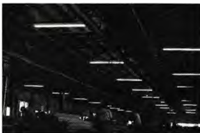
日本建鉄（千葉） FHR-1102 (110 W×2 灯) 工場用 反射ガヤ付器具.
