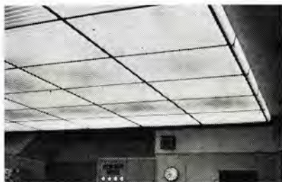
③6 中部電力新名古屋火力発電所配電盤室 (名古屋) 波形アクリライト板を使用した光天井方式で天井面の明るさの差を少なくするため約 100 mm 天井面より下げた構造。ケイ 光灯 FLR-40 W-D×126 灯+白熱電球 40 W (非常灯)×23 灯。照度は机上面 930 lx, 盤面上部 510 lx. 盤面中部 360 lx.
