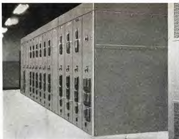
関西電力大坂発電所納め メタルクラッド 配電盤 Metal clad switchgear for Kansai Electric Power Co.
