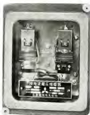
SE 形接地過電圧継電器 Type SE ground overvoltage relay.
