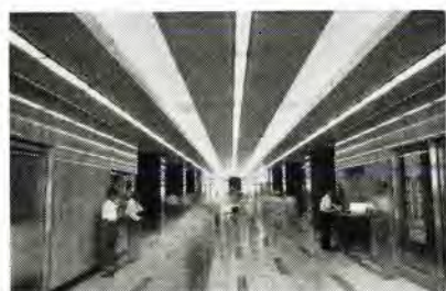
⑤ 新大手町ビル（東京）1 階入口ホール FL-40 W×1 灯用乳白色アクリライトカバー半埋込連続 38 連器具×3 列と間接照明による組合わせ照明、床上 240 lx.
