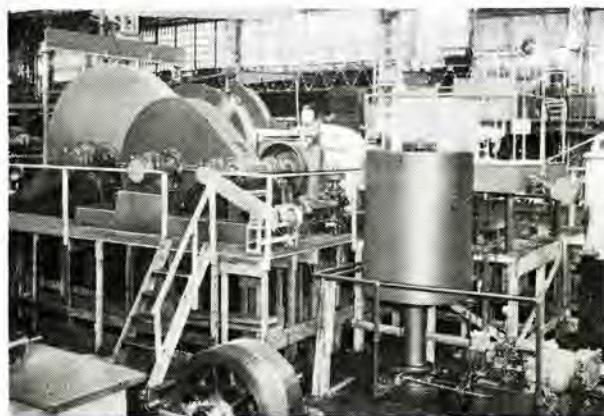
麻生産業納め 300 kW 単胴巻上機 300 kW single drum hoisting machine.
