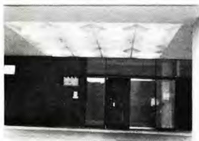
⑪ 北鉄病院（金沢）玄関車寄せのデラックスパネル 34C×20 枚使用の埋込照明による光天井。
