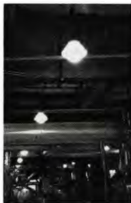
③5 関西電力大阪火力発電所 (大阪) HF-200 透明ヒダ付ガラスグローブ器具。
