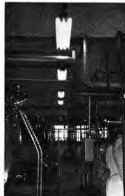
⑨ 森永乳業西宮工場(西宮)ビル詰室 FHR-C402 (FLR-40W×2灯用)防湿耐食形器具使用。
