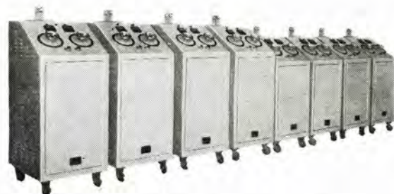
3 kW および 7.5 kW ゲルマニウム 整流器 3 kW and 7.5 kW germanium rectifiers.
