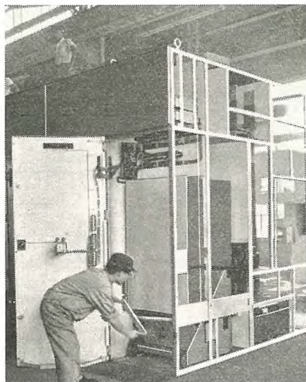
図 3.6 シャ断器引出操作 Fig. 3.6 Rolling out operation for circuit breaker.
