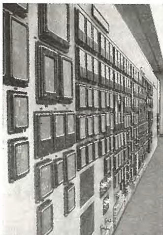
図 4.1 中央制御室用継電器盤 (関西電力姫路発電所 1, 2 号機用) (図 3.1 および図 3.2 に示す発電機盤の裏面盤)
