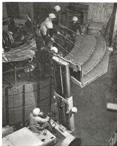
図 III. 3.1 回転子リム積 (フォークリフトの使用) Fig. III. 3.1 Building the spider rim (by use of fork lift truck).
