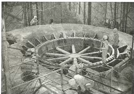
図 II. 4.3 ケーシング水圧試験
