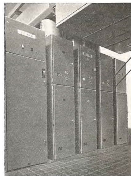
図 2.3 離相形主回路キュービクル Fig. 2.3 Isolated phase type cubicles for main circuit.
