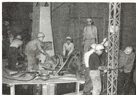
図 III. 3.3 回転子リム積 (ドロップハンマによるリーマボルト打込) Fig. III. 3.3 Building the spider rim (driving reamer bolts with drop hammer).
