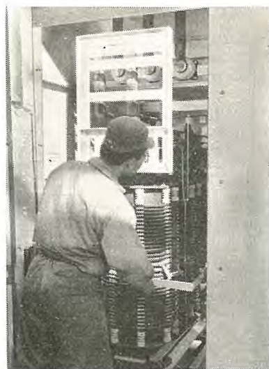
図 5.9 変圧器装着作業
