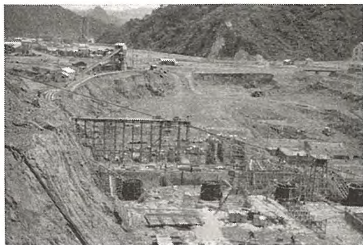
図 II. 3.2 すえ付完了の吸出管 Fig. II. 3.2 Installed draft tubes.
