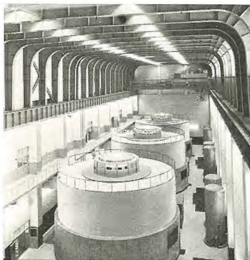
図 2.1 105,000 kVA カサ形水車発電機
