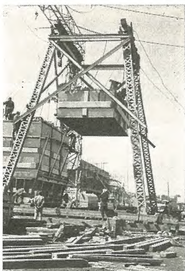
図 5.8 現地で上部タンクをかぶせている 312,000 kVA 変圧器
