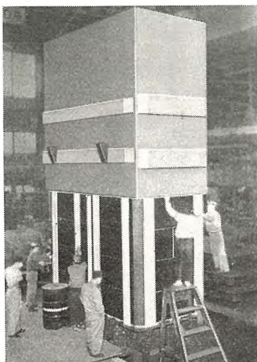
図 5.4 中部タンクかぶせ作業 Fig. 5.4 Covering middle tank.
