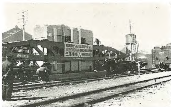
図 5.11 鉄道により組立輸送を行なう 312,000 kVA 変圧器の 1 相
