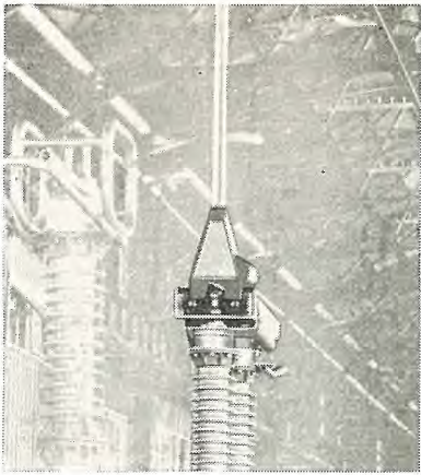
図 2.5 開路のときの機構部 Fig. 2.5 Mechanism in open condition.
