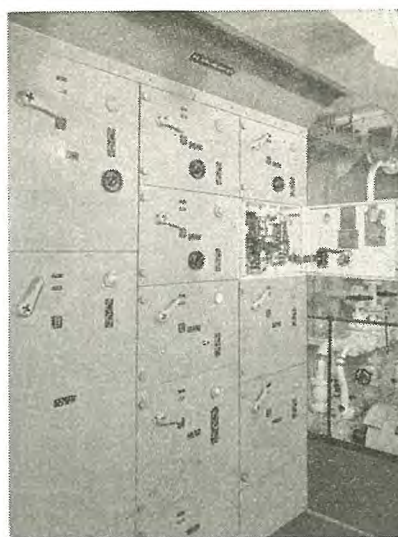
図 5.4 集合起動盤 Fig. 5.4 Group control starter.
