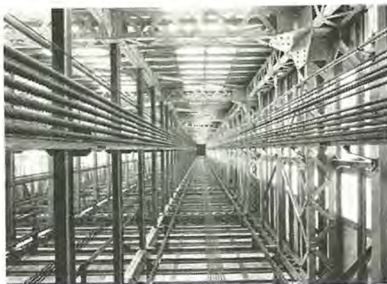
図 4.1 A 群エレベータ昇降路 カゴ上より頂部を望む ガラス窓の関係で非常に明るい
