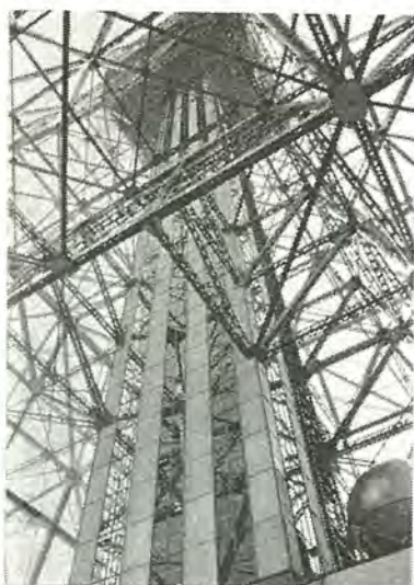
図 2.1 A 群エレベータ昇降路近景 ガラス窓の部分はエレベータカゴ室の窓と相對して 外景の展望ができる
