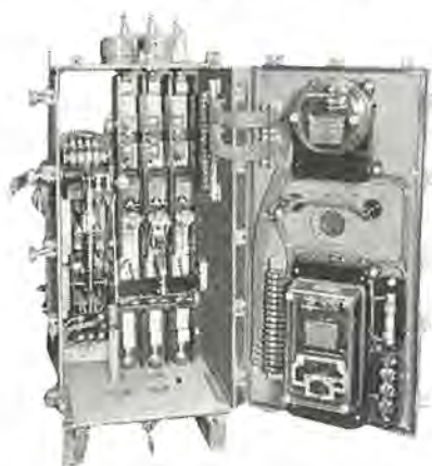
図 5.5 ネットワークプロテクタの外観 Fig. 5.5 Network protector.
