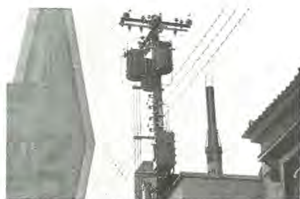
図 5.7 ネットワーク変圧器およびプロテクタの装柱
