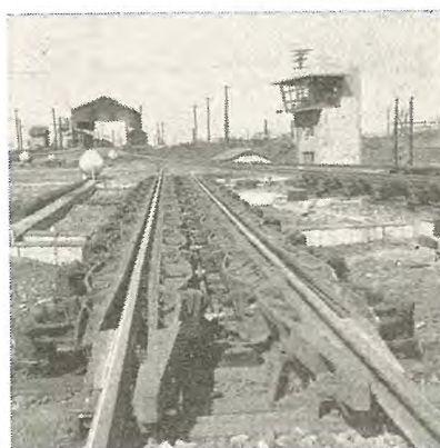
図 2.1 操車場における第2カー・レターダ レールの左右から空気圧力により車両を締めつける。 入口から出口までの距離は約20m
