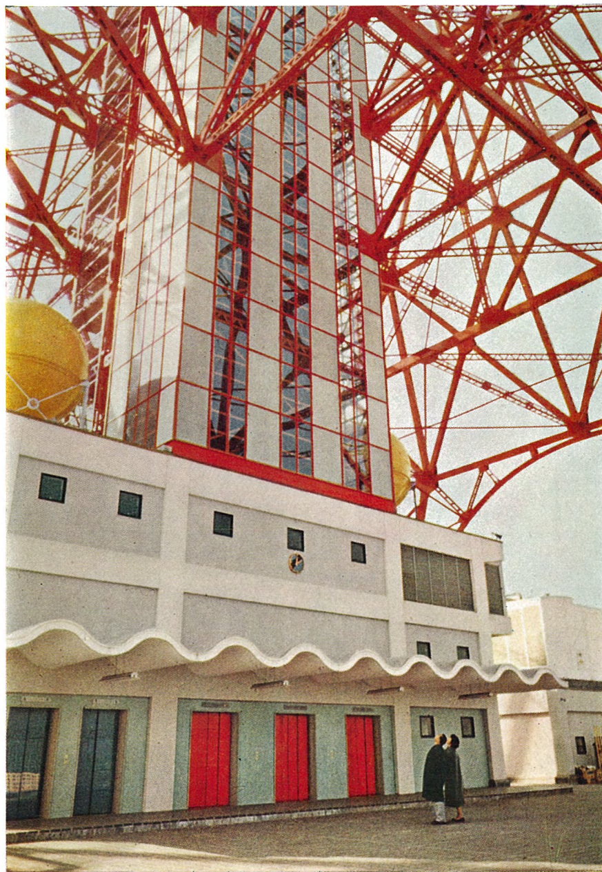
科学館屋上の東京タワーエレベータ乗場
