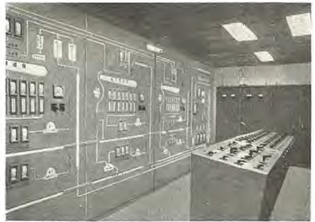
富士製鉄室蘭焼結設備用照光盤および作盤 Control panel for sintering plant.
