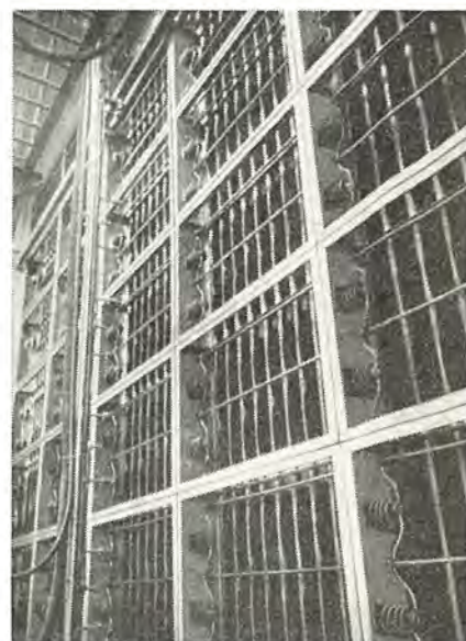
CH-750-D 形クリネヤ（空気流入側） Type CH-750-D cleanair (Air inlet side).
