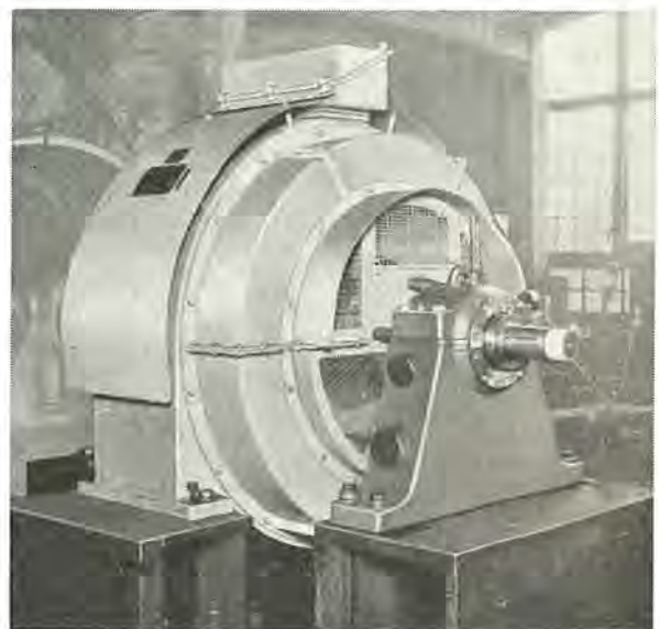
三菱長崎造船所納 AVR なし自励交流発電機 300 kVA 514 rpm 14 P
