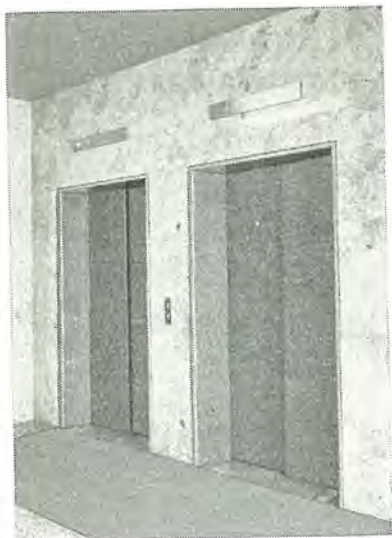
高松第一生命ビルギヤードエレベータ乗場 1,100 kg 105 m/min Entrance for DC geared elevator.
