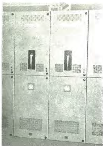
名古屋市電新那古野変電所給電線 キュービクル(正面) Feeder line cubicle of Nagoya Municipal Railway.
