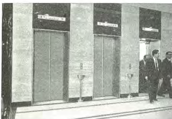
大手町ビル 9~11 号機 1,000 kg 150 m/min ギヤレスエレベータ Gearless elevator 1,000 kg 150 m/min.
