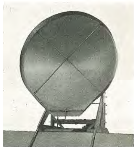
6,000 Mc パラボラアンテナ 6,000 Mc parabola antenna.
