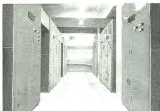
東京電力大手町変電所納 23 kV 屋内用 1,200 A 1,000 MVA キュービクル開閉装置 23 kV 1,200 A 1,000 MVA indoor cubicle switchgear for Otemachi substation, Tokyo Electric Power Company
