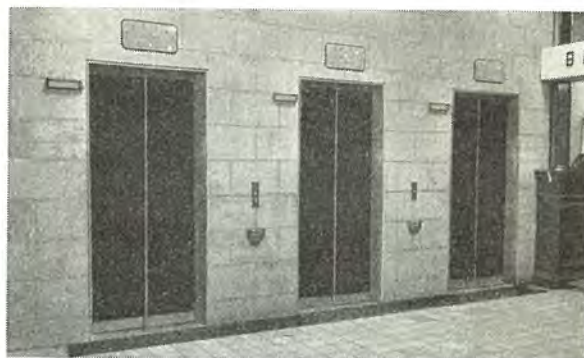
大ビル本館ギヤレスエレベータ乗場 3 台バンク 800 kg 150 m/min Entrance for gearless elevators.
