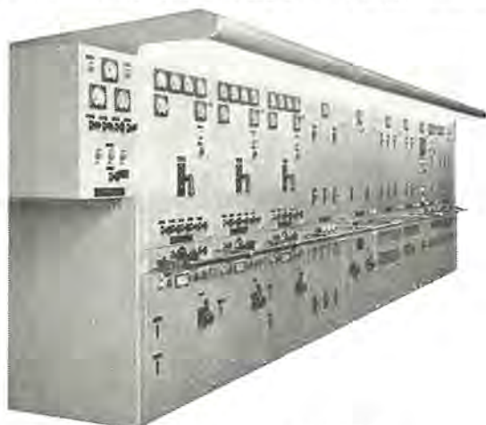
大阪商船もんてびでお丸納配電盤 Marine switchboard.
