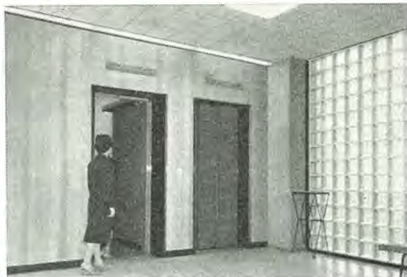
北海道自治会館エレベータ乗場 G.D. 2カー セレクトチブ コレクチブ ジューアル操作 800 kg 90 m/min 直流全自動
