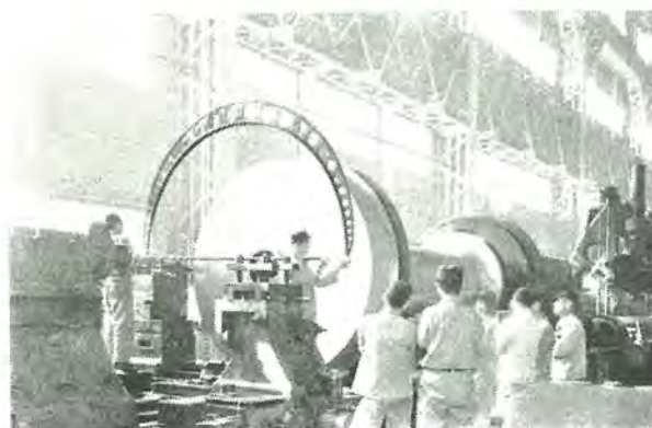
田子倉発電所向主軸 Main shaft.
