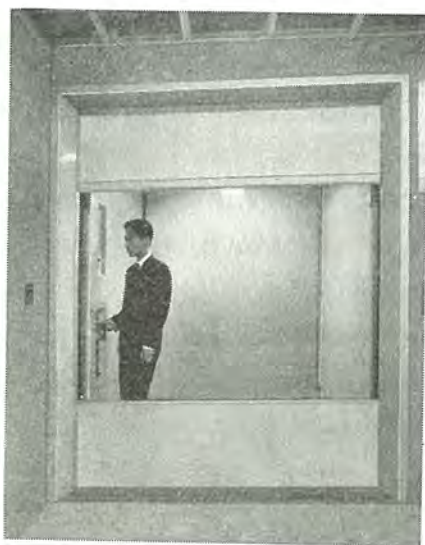
朝日新聞社（東京）貨物エレベータ 3,000 kg 30 m/min 二段速度 乗場の扉は電動上下開閉 C 形扉 AC 2 Speed 3,000 kg 30 m/min freight elevator.
