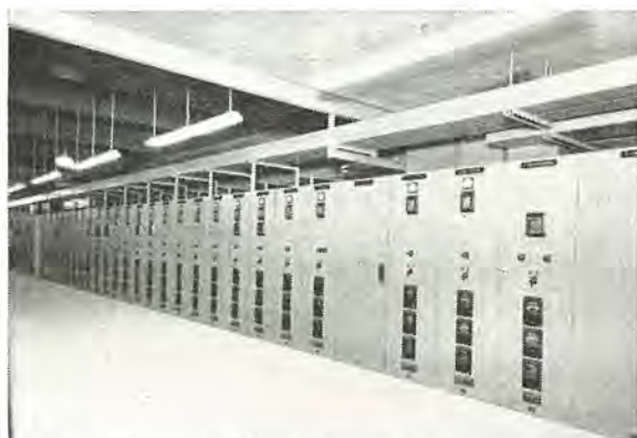
中国電力新宇部発電所納 火力発電所補機用メタルクラッド配電盤 Metal clad switchboards for auxiliaries of steam power plant.
