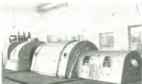
日本セメント上磯工場 13,333 kVA (12,000 kW) タービン発電機 Turbine generator 13,333 kVA for Nippon Cement.
