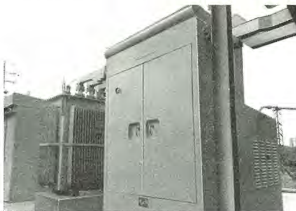
三菱化成黒崎工場納 125 V 2,100 A シリコン整流器 屋外形のシャ断器, 変圧器, シリコン整流器の外観 View of silicon rectifier installation in Kurosaki Works, Mitsubishikasei. This unit is rated at 2,100A 125 V DC.
