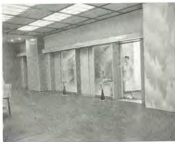
帝国ホテル第二新館ギャレスエレベータ 1,200 kg 105 m/min Gearless elevator 1,200 kg 105 m/min.
