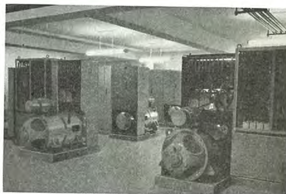
新大ビルエレベータ機械室 ギヤレスエレベータ 3 台バンク計 6 台 Machine room for gearless elevator.
