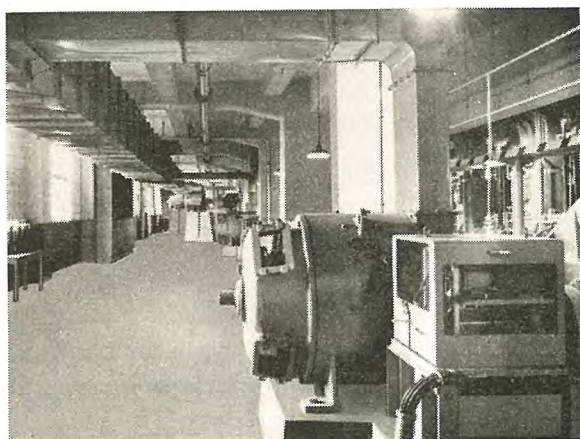
図 4.5 差動歯車式速度調整器を取付けたセクション電動機 Fig. 4.5 Section motor couple to differential gear regulator.
