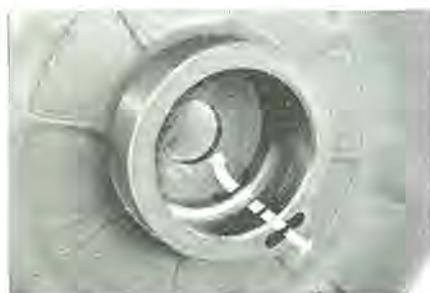
図 5.20 SF-A 形 ブラケットのバイパス部 Fig. 5.20 Bypass part of type SF-A bracket.
