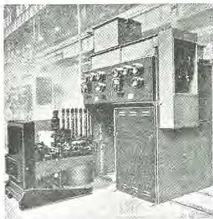
図 2.1 WB 形油入遮断器メタルクラッド配電盤
