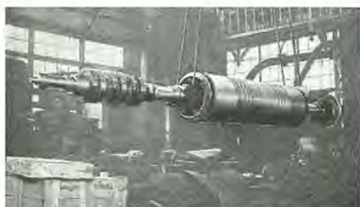
図 2.9 巻線形回転子 (高速度)
