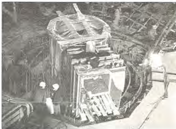
JRR-II 原子炉の熱中性子柱
