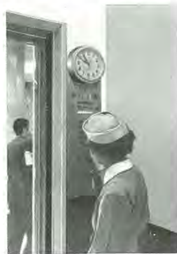
図 4.2 各カゴ内に電気時計を仮設して時刻の同期を保たす
