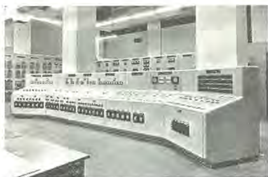
図 7.1 三菱地所大手町ビル納入の監視制御盤 Fig. 7.1 Supervisory control board supplied to Otemachi bldg.
