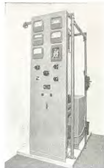
図 4.6 静止励磁器および発電機盤のすえ付 Fig. 4.6 Installation of static exciter and generator panel.
