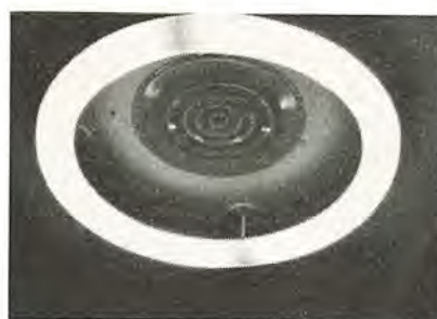
図 4.18 アネモスタット (照明器具とマッチさせてある)
