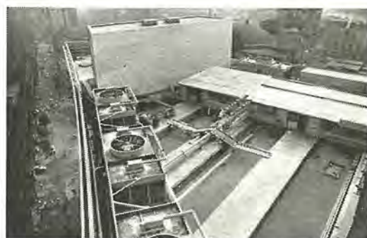
図 4.11 (b) 冷却塔
