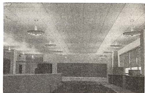
図 72 円形ルーバ付シルバー・ボール白熱電球による実験室の照明
