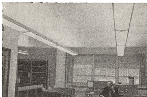
図 68 図書室のスリムライン 96" T-12×2 灯用パイプつり下器具で平均 650 lx の照度
