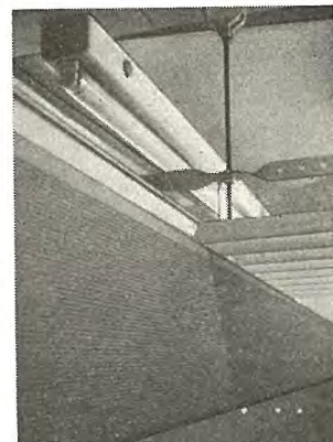
図 6.4 吸音バッフル およびバッフル支持わく のつり方 Fig. 6.4 Perforated acoustic baffle and suspension of hold- frames.
