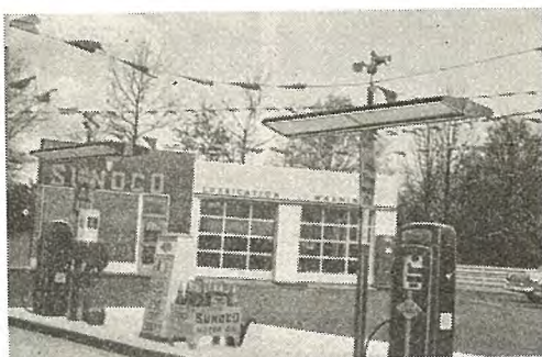
図 47 ガソリンスタンドの蛍光灯、投光電球による照明
