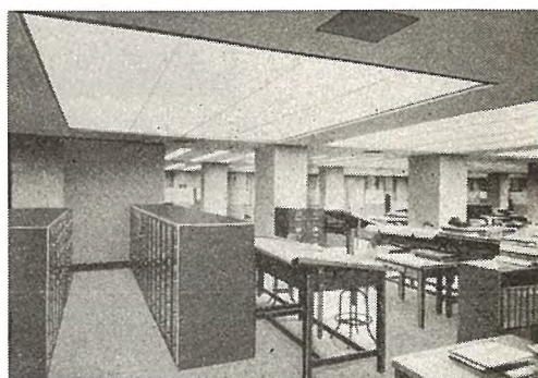
図 57 フィラデルフィア電力会社設計室の光り天井
