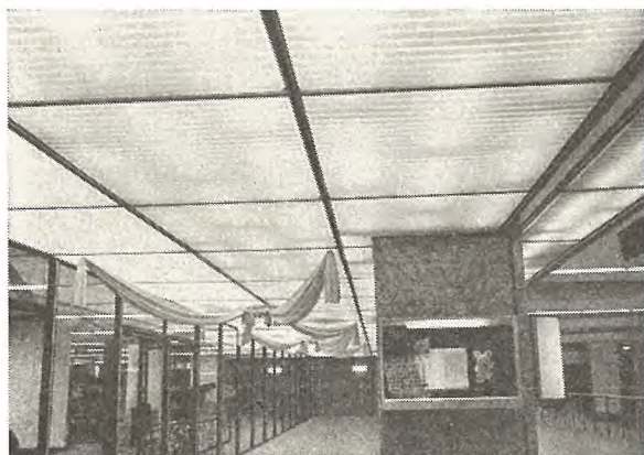
図 9.5 地階入口の光り天井照明
