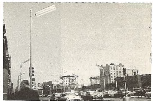
図 41 ニューヨーク・ダウンタウンの高出力形蛍光灯による街路照明
