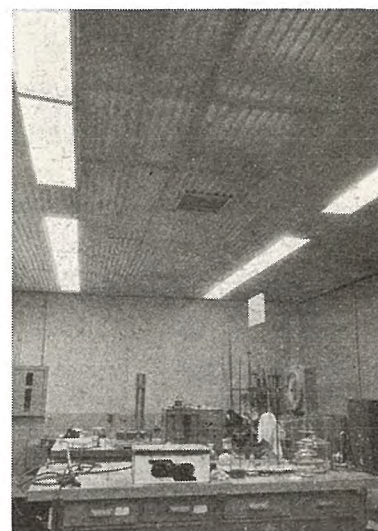
図 5.3 昼間は天空光を入れ、夜は埋込まれた蛍光灯で照明するプラスチックの天井 Plastic ceiling using sky light in the daytime and fluorescent light at night.
