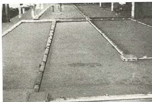
図 76 工事現場におけるフロアダクトの例
