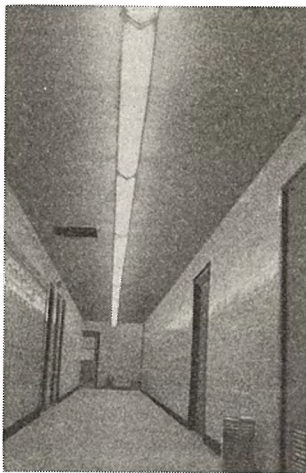
図 67 廊下およびロッカのルーバ付蛍光灯のライン照明
