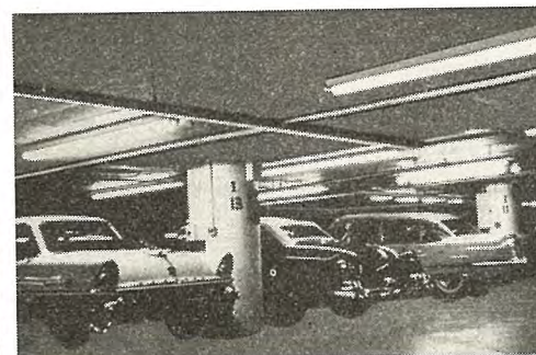
図 50 ロスアンゼルス市の地下駐車場の蛍光灯照明（地下 3—4 階）
