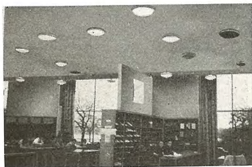
図 74 同大学 1 階図書室の円形ルーバ付シルバーボール白熱電球の照明
