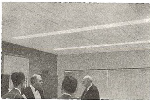
図 66 一般教室の蛍光灯埋込器具による照明で平均照度 550 lx
