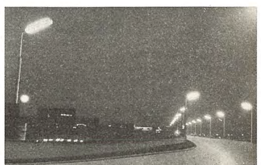
図 43 フェアモント市の橋梁の照明 (高出力ラビッドスタート蛍光灯 72" T-12×4 灯付街路灯)
