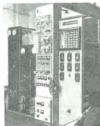
図 6.11 遠方監視制御継電器盤
