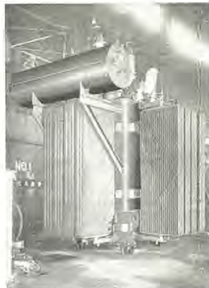
図 3.1 四国電力津賀発電所の単巻変圧器 100 kV (60 号)/50 kV (30 号), 10,000 kVA.
