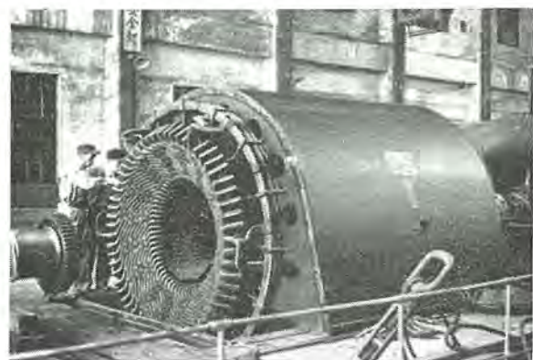
図 1.1 (b) 同左ロータを抜いたところ
