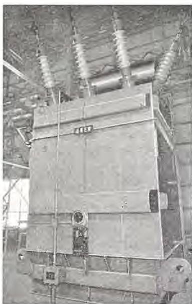
図 1 東京電力新東京火力発電所向 92,000 kVA 変圧器 (屋内設置)
