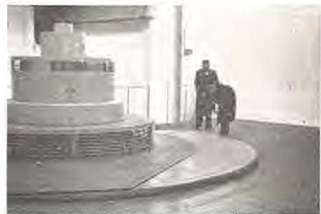
図 4.1 昨年完成した或る新設水力発電所で軸電流によりスラスト・メタルを焼損した発電機
