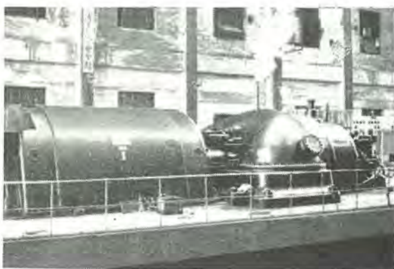
図 1.1 (a) 供試発電機 (27,500 kVA, 11 kV 50 s/c)
