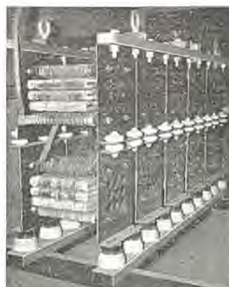
図 5.1 徳山ソーダ発電機中性点抵抗器 発電機 7,000 kVA 抵抗値 9.5 \Omega
