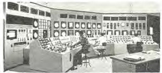
図 4.3 PWR 発電所の主制御室
