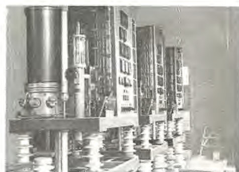
図 6.5 高圧イグナイトロンインバータ (高島側)
