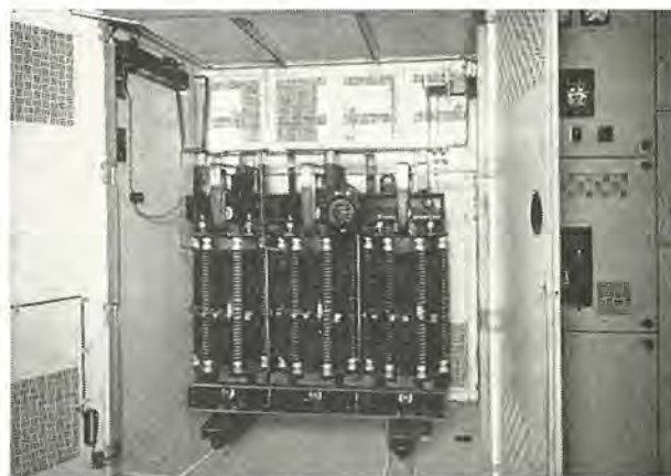
図 8.8 500 kVA パワーセンタ AV 形乾式変圧器 3 φ 60 c/s 3.3 kV/220 V
