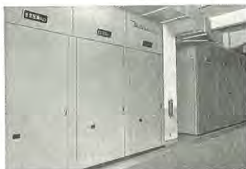
図 1.1 20 kV 変圧器キュービクル外観
