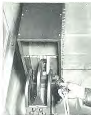
図 2 コンタクトおよび消弧室の点検状況
