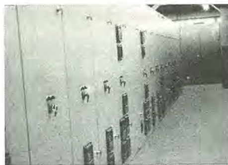
図 6.1 変圧メタルクラッド配電盤
