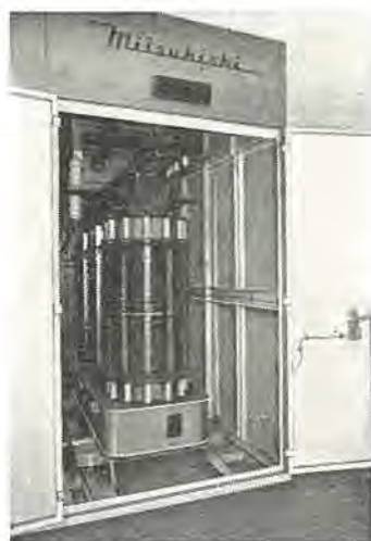
図 1.2 20 kV 変圧器キュービクル内部
