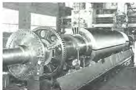
機工中の内部冷却回転子
