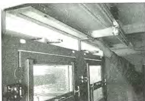
図 4.14 整流タンク上部の開閉装置ハンドル Fig. 4.14 Handle above rectifier.
