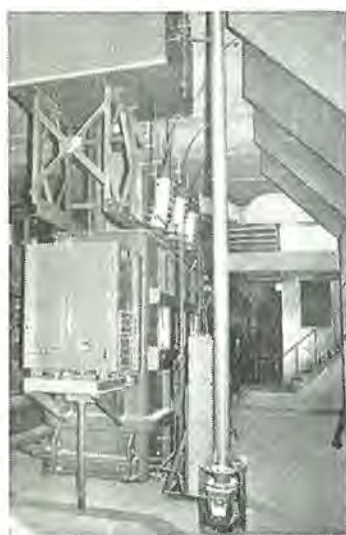
図 3.3 6,000kVA 負荷時タップ切替変圧器 Fig. 3.3 6,000kVA Transformer with on-load tap changer.
