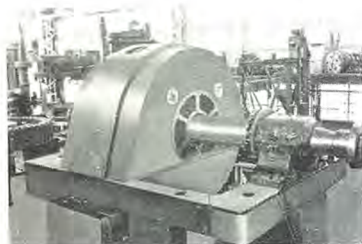
富士製鉄 (室蘭) 納同期電動機 8,000 HP 6,000 V 3φ 50~600 rpm Pf=0.9 進み 閉鎖風道換気形直流発電機駆動用 8,000 HP synchronous motor for driving d-c generator.
