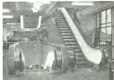
池袋三越納 1200 L 型エスカレータ Type 1200 L escalators for Ikebukuro Mitsukoshi dept. store in Tokyo.
