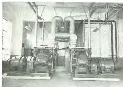
東京都立芝浦屠場納, MB-8C-N 型冷凍機 Refrigerator for Shibaura butcher house in Tokyo.
