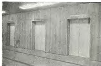
東京貿易会館納ギヤレスエレベータ 1,600 kg, 150 m/min D-C gearless elevators 1,600 kg, 150 m/min for Tokyo Boeki Kaikan in Tokyo.
