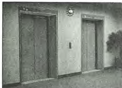
神戸国際会館納ギヤレスエレベータ 1,000 kg, 120 m/min D-C gearless elevators 1,000 kg, 120 m/min for Kobe Kokusai Kaikan.
