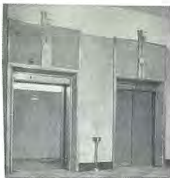
名古屋大和生命納ギヤレスエレベータ 1,200 kg, 120 m/min D-C gearless elevators 1,200 kg, 120 m/min Yamato Seimei Bdg. in Nagoya.
