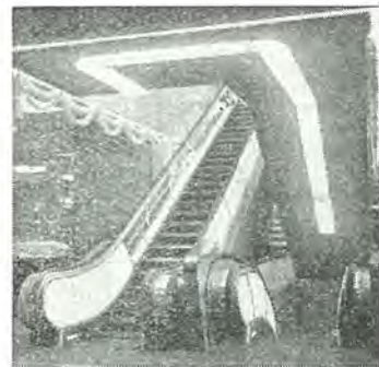
新宿伊勢丹納 1200 S 型複列交叉エスカレータ 12 基 Type S criss-cross escalators 12 sets for Isetan dept. store in Tokyo.
