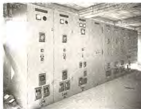
住友化成大江工場納屋内用メタルクラッド配電盤 Outdoor metal-clad switchboard for Sumitomo Kasei.
