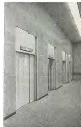
上野松坂屋納ギヤレスエレベータ 2,250 kg, 105 m/min D-C gearless elevators 2,250 kg, 105 m/min for Ueno Matsuzakaya dept. store in Tokyo.
