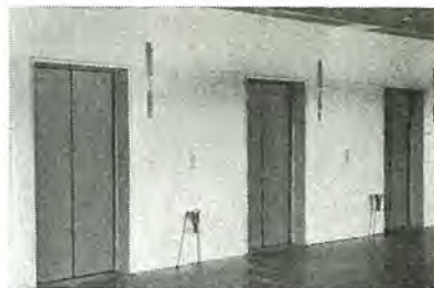
神戸市役所納直流ギヤードエレベータ 1,100 kg, 105 m/min D-C geared elevators 1,100 kg, 105 m/min for Kobe city office.
