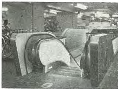
新宿伊勢丹納 1200 S 型エスカレータと 防火シャッター Type 1200S escalators and fire shutters for Isetan dept. store in Tokyo.
