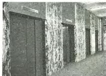
阪急百貨店納ギヤレスエレベータ 2,250 kg, 150 m/min D-C gearless elevators 2,250 kg, 150 m/min for Hankyu dept. store in Osaka.
