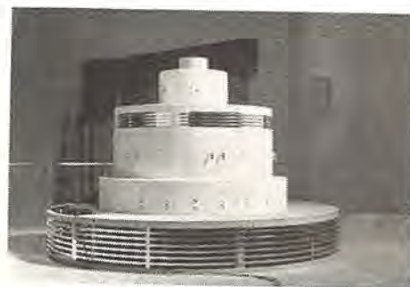
東北電力 鳴子納 22,000 kVA 発電機 A-C generator.
