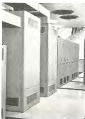
図 1. 栄町変電所主変圧器および高圧側キュービクル
