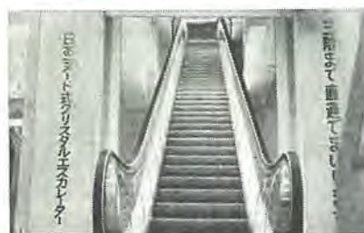
熊本鶴屋百貨店納 1200 LS 型 エスカレータ全長 18 m Type 1200 LS escalator total length 18 m for Tsuruya dept. store in Kumamoto.
