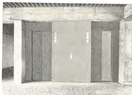
東京都庁納ギヤレスエレベータ乗場回り全部鋼板塗装 D-C gearless elevators for Tokyo metropolitan office.
