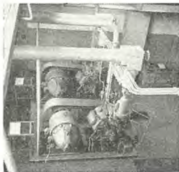
宮城酪農農業協同組合納ヒートポンプ 式 MA-6B-N 型冷凍装置 Heat-pump type refrigerating machines for Miyagi dairy farming cooperative association.
