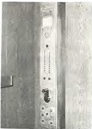
そご百貨店納客用エレベータ カゴ操作盤と木目塗装パネル Car station and cab of passen- ger elevators for Sogo dept. store in Tokyo.
