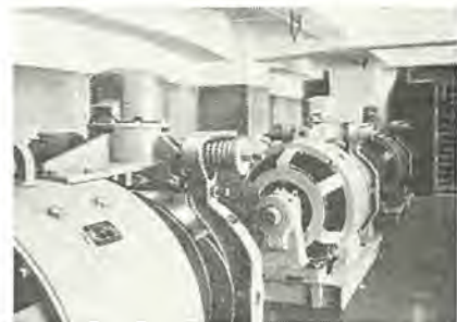
名鉄ビル オート・セレクトボタン・オートギヤレス巻上機 D-C gearless traction machines for Meitetsu Bldg. in Nagoya.
