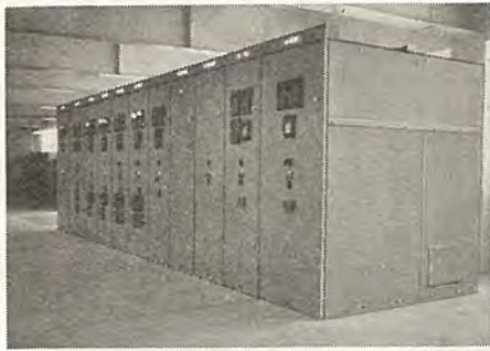
関西電力姫路発電所納メタルクラッド配電盤
