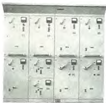
A-C グループコントロール (55HP 以下 9 台組込) A-C group control
