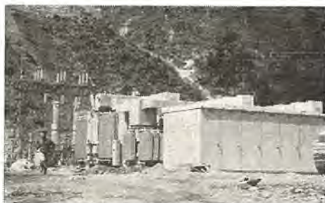
東北電力鳴子発電所納屋外用メタルクラッド配電盤 Outdoor metal-clad switchboard for Tohoku Electric Power Co.
