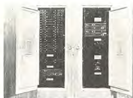
読売会館納 BH-NF 形ノーヒューズ分電盤扉付き、 表板が装飾木板のもの No-fuse distribution panel.
