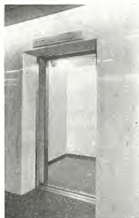
東京貿易会館納ギヤレスエレベータ三方枠を縮めた例 D-C gearless elevators for Tokyo Boeki Kaikan in Tokyo.
