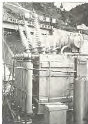
関西電力坂下発電所納 45,000 kVA 変圧器 45,000 kVA transformer for Kansai Elec. Power Co.
