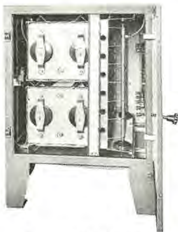
8 図 CC-2B 型クリーネヤ 内部構造
