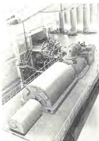
図 1 姫路発電所に設置した 75,000 kW タービン発電機 pF=85%, SCR 0.64, 13,800 V, 3 相, 60 c/s
