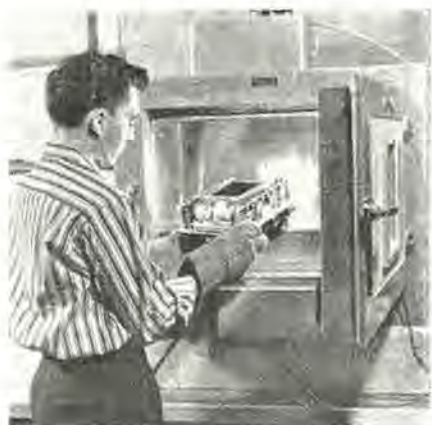
温度試験のため炉中におかれるレーダカップラ
