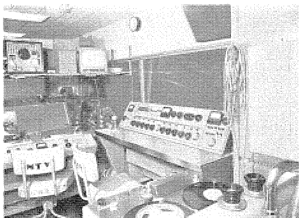
26 図 テレビホール副調整室内機器据付状況 中央は調整卓その左レコードプレーヤ
