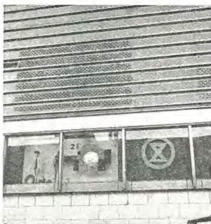
7 図 新鮮空気取入口 ガラスブロック 1 個毎に穴をあけてある。この裏側に水 切りルーバが取り付けられている。
