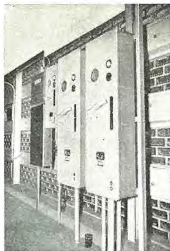
4 図 塔屋 4 階の機械室にあるコン ビネーションラインスタータ 左端は空気調和自動装置の電 子管パネルを示す。
