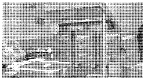
30 図 厨房炊飯室 中央は3段1斗5升炊飯器3台 右手前は貯米装置のタンク、下部は洗米器、左側は野菜洗3槽流しがある。 Fig. 30. Rice cooking arrangement.
