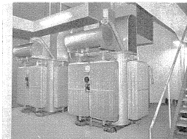
2 図 油入自冷式変圧器（読売会館納入） 3 \phi 2,000 kVA 22/3.3 kV 50 c/s
