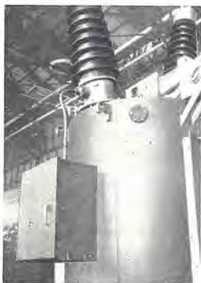
9 図 ブッシング型電位変成器 (P. D) (油入遮断器取付)
