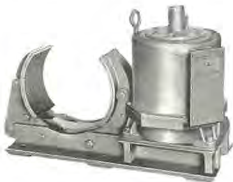
1 図 SA 1665 型電磁ブレーキ Fig 1. Type SA-1665 magnetic brake.
