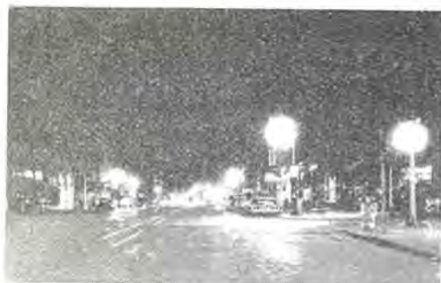
1 図(左) 2 図(右) Manhattan 3 番街における新型蛍光燈器具による街路照明の施設前(1 図)および後の対照。全長 7 \frac{1}{2} マイルにわたって 539 組の新型器具の設置によって照明が改善されている。
