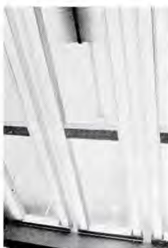
1 図 米国照明学会事務室の高出力ラビッドスタート 96" T-12 蛍光灯 × 6 燈の半間接照明施設
