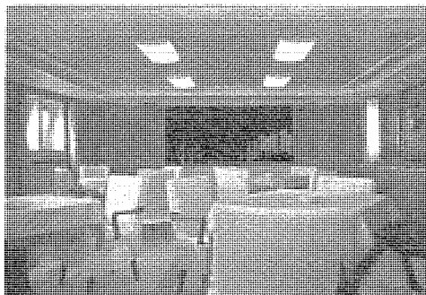
14 図 サロン半埋込型 20W×2 Fig. 14. Semi-flush type lighting fixture.
