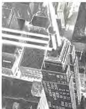
4 図 エンパイヤ・ステート・ビル塔上の水銀ショート・アークランプ 2,500 W×4 セットによるサーチライト
