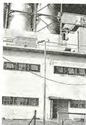
2 図 2 号機屋外変電設備四隅に取付けられた RH-300 W 2 燈用投光器 (ポール 5.5 m 付)
