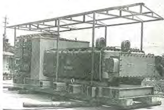
19 図 300 kVA 耐圧防爆型パワーセンタ (屋外用)
