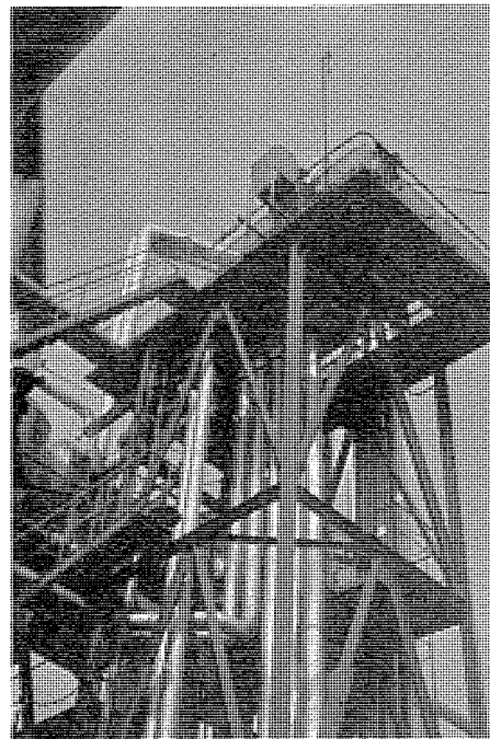
4 図 基地局空中線 Fig. 4. 150 Mc/FM antenna for Kurosaki station.
