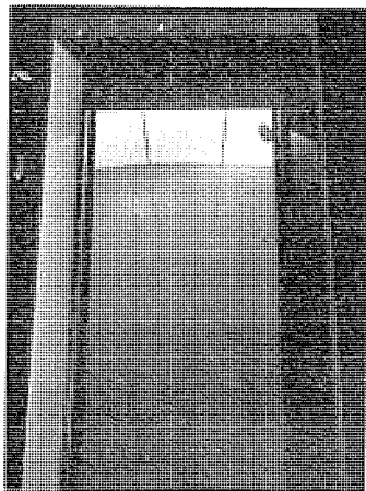
8 図 カゴ室照明 ポリエステル板2重天井照明 (神戸国際会館納)
