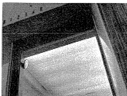
3 図 カゴ室照明 アクリ板吊天井 (大阪テレビ納)
