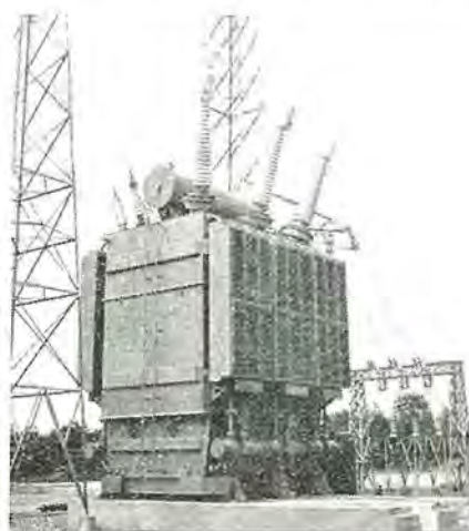
関西電力枚方変電所納 3φ 117,000 kVA 250 kV 特別 3 相式変圧器 Special 3 phase transformer.
