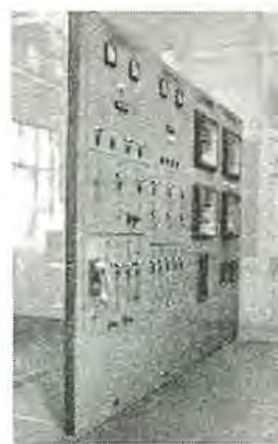
国鉄四条畷発電所納遠方監視制御装置 (京橋変電所に設置) Supervisory control panel.
