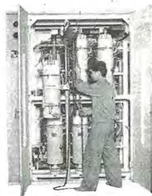
1,000 kW 水冷式密封型イグナイトロン整流器の整流タンクの取替状況を示す。整流タンクは容易に取りはずすことができる。
