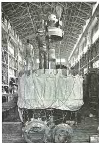
8 図 スパイダリムをスパイダボスに取付中を示す Fig. 8. Fitting the spider rim to the spider boss.
