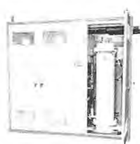
左写真のイグナイトロン水冷式再冷 器の格納状況を示す。
