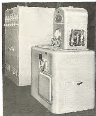
16 図 水車制御盤および AⅢ 型調速機 Fig. 16. Turbine control cubicle and Type AⅢ actuator.
