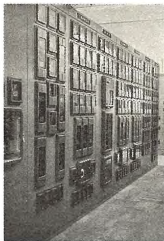
28 図 主配電盤継電器面 Fig. 28. Relay panel of main switchboard.
