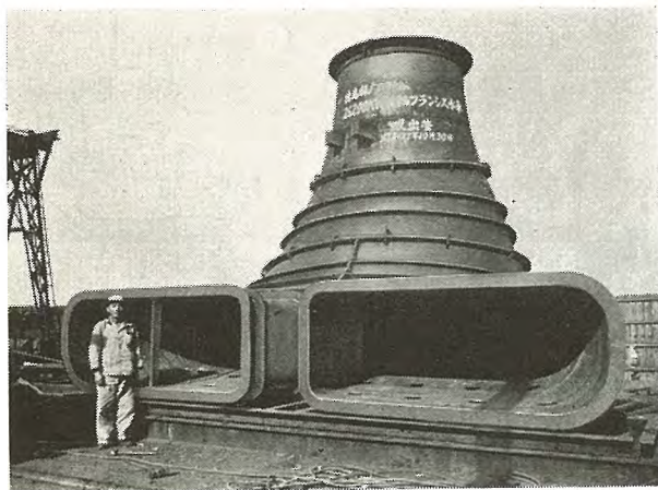
15 図 吸出管ライナ Fig. 15. Draft tube liner.
