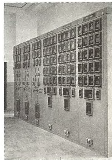
29 図 運転制御盤、自動電圧調整器盤 Fig. 29. Automatic control, and automatic voltage regulating panel.
