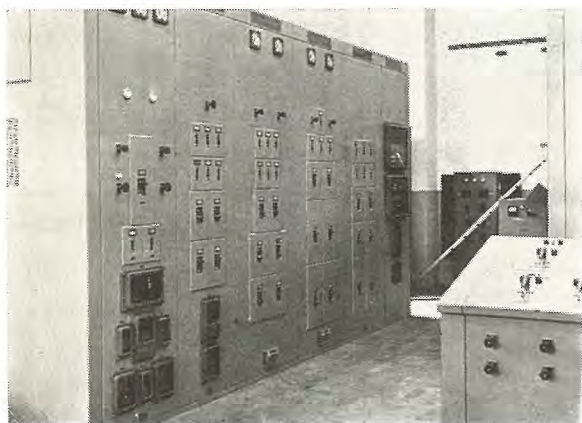
30 図 所内低圧盤および自動同期盤
