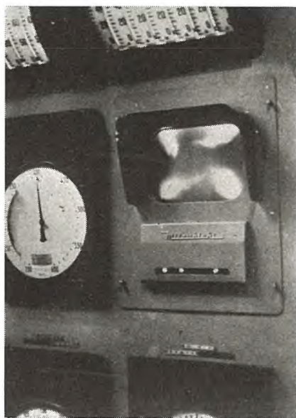
7 図 計器盤前面より制御監視機画面を見た所、受像画面は重油バーナ点火時の炉内状況
