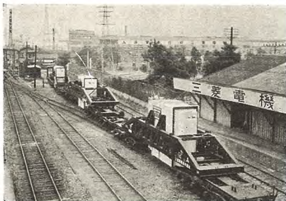
25 図 シキ 120 号 1 台シキ 150 号 2 台の 3 両編成で各相ごとに組立輸送を行う 93,000 kVA 変圧器
