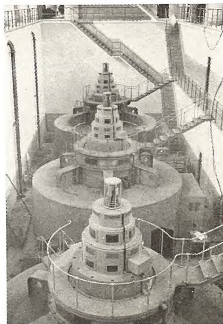
日野谷発電所納 24,000 kVA 水車発電機
