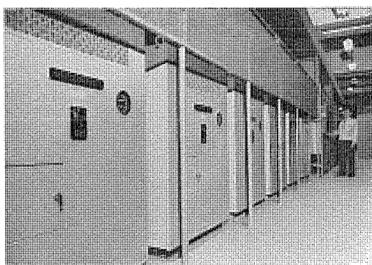
5 図 乾式変圧器 (鉄道会館納) 1φ 150 kVA 3,300/210 V Fig. 5. Dry type transformer.
