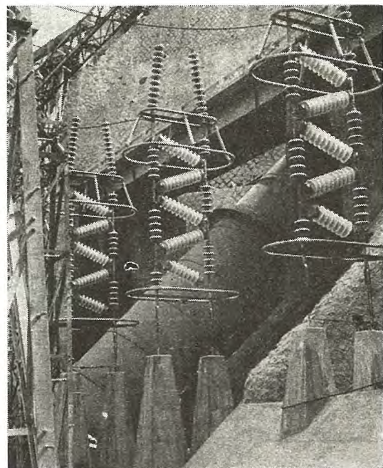
1 図 関西電力丸山発電所において運転中のSV-W型140kVオートバルブ避雷器(許容端子電圧196kV) Fig. 1. Type SV-W 140kV autovalve lightning arresters installed at Maruyama Power Station of the Kansai Electric Power Company.
