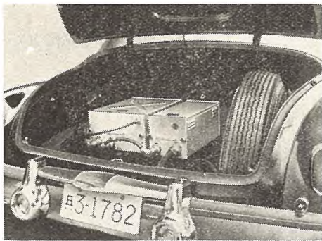
FM-1 型 150 Mc/FM 超短波無線機 移動用 (25 W) FM-1, 150 Mc, FM communication set, mobile type (25 W).
