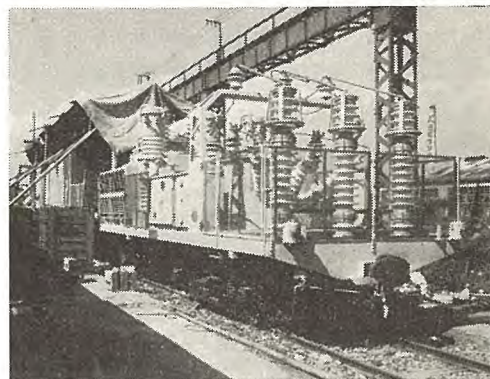
機装中の電鉄用移動変電所直流 600 V 1,500 kW
