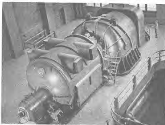
1 図 水素冷却機（水平かつ軸に直角な冷却器付）
