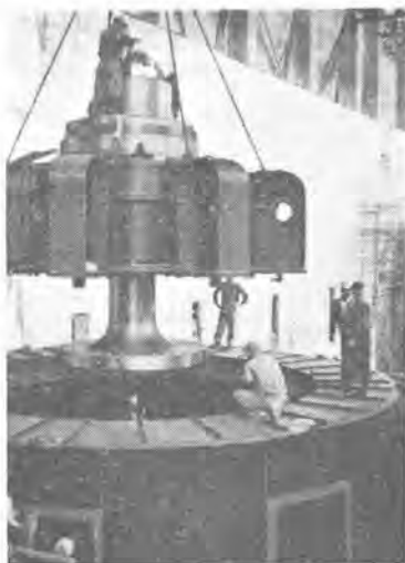
23 図 スラスト部分の吊込 Fig. 23. Inserting the part of thrust bearing.
