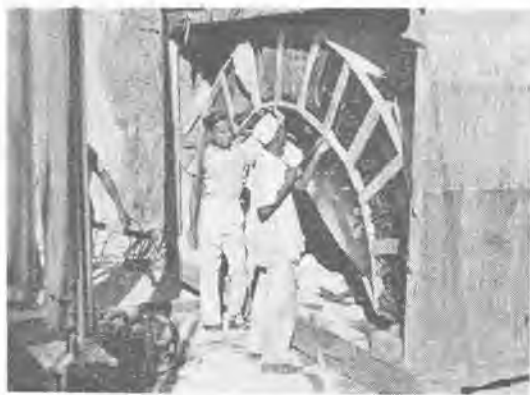
4 図 ステータの開箱 Fig. 4. Unpacking of casing.
