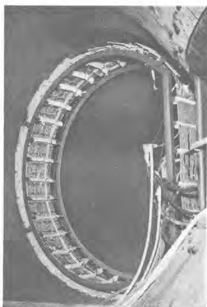
6 図 スパイラルケーシング現場焼鈍状況 Fig. 6. Annealing of spiral casing at site.
