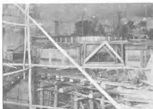
11 図 某 30,000 kVA カプラン水車発電機リム積作業 Fig. 11. Rim piling work of 30,000 kVA Kaplan turbine generator.
