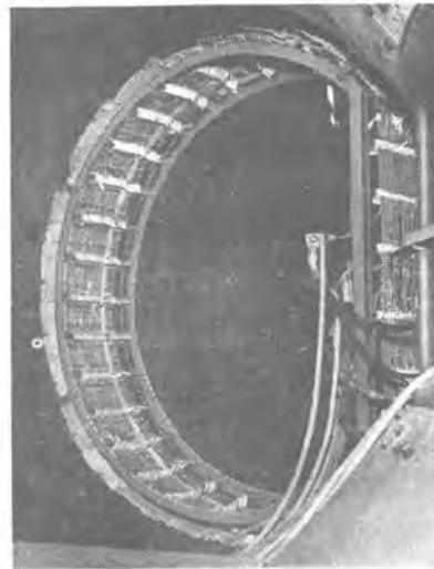
14 図 円周接手の焼鈍装置 Fig. 14. Annealing of circumferential joint.
