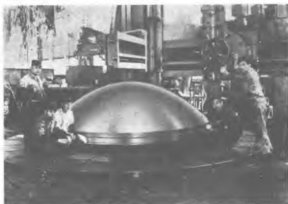
12 図 パラボラのプレス押型の面削り
