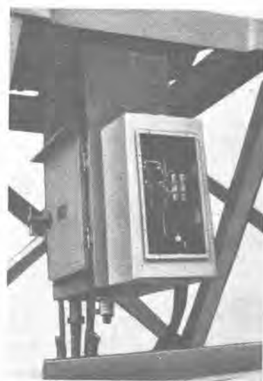
3 図 屋外結合装置取付状況
