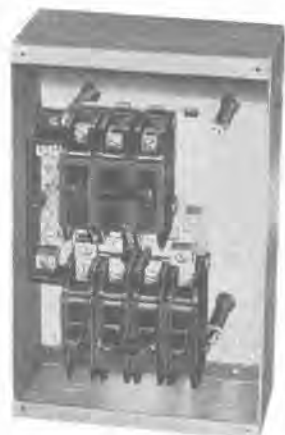
6 図 クイックラダグロードセンタ内部構造
