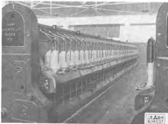
4図A 始紡機 Fig. 4 A. Slubbing frame.
