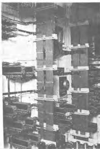
12 図 制御盤裏面配線の一部 Fig. 12. A part of back wiring of controlling.
