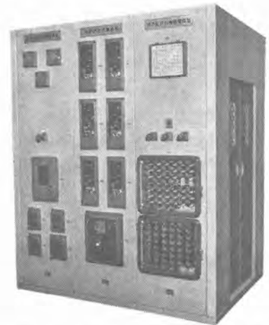
11 図 被制御所（笠寺変電所）に設置される装置 Fig. 11. Equipment in controlled station (Kasadera substation).
