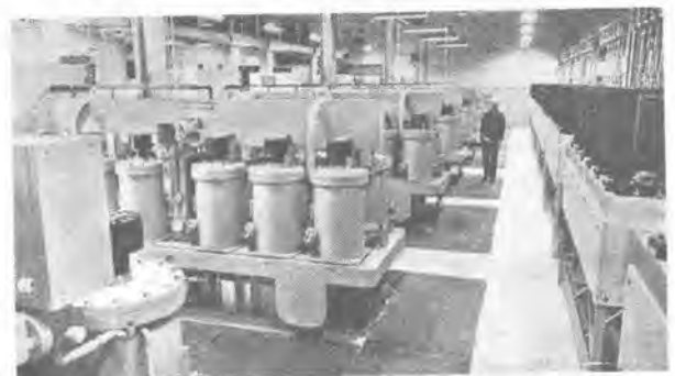
3 図 化学工業用イグナイトロン変電所 Fig. 3. Installation of ignitron rectifiers in electro-chemical plants.
