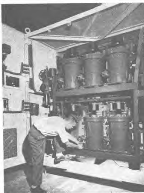
11 図 キュービクルに挿入した 1,000 kW, 250 V イグナイトロン
