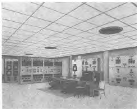
3 図 米国における光り天井照明の一例 机上面平均水平照度 450 lx 配電盤上部での垂直照度 180 lx
