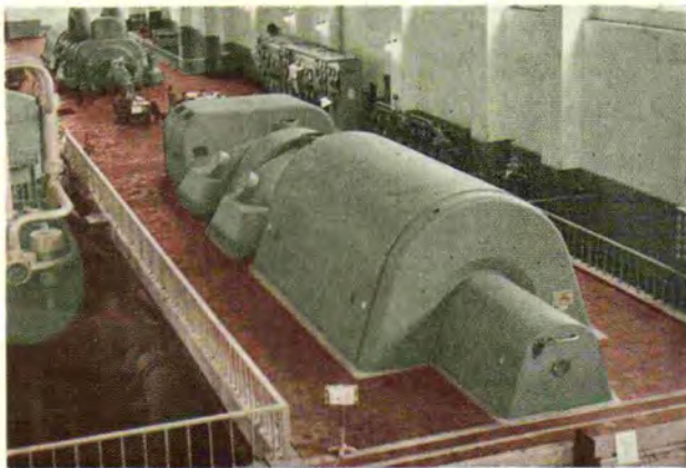
九州電力築上発電所 (55,000 kW タービン発電機)
