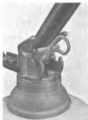
30 図 DBA 型ヒューズヒンジ側コンタクト部 Fig. 30. DBA fuse hinge side contact.
