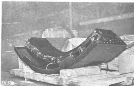
3 図 固定子枠の四分割
