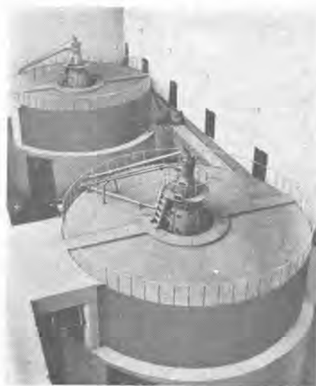
1 図 30,000 kVA 傘型発電機。
