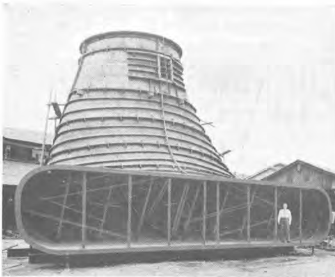
11 図 吸出管工場組立状況
