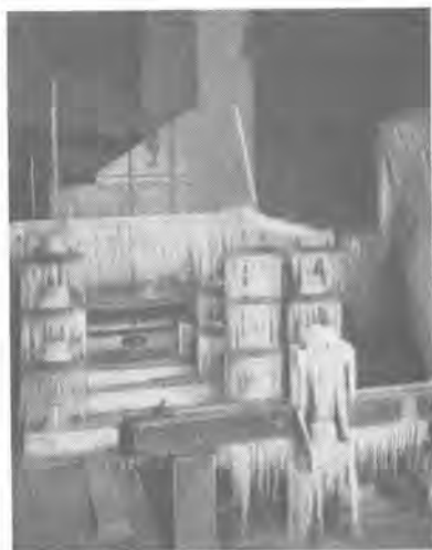
27 図 アメリカ W 社にて 氷結試験中の V 型断路器
