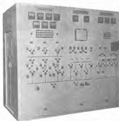
イグナイロン制御配電盤 (刈谷変電所) Control panel for ignitron rectifier.
