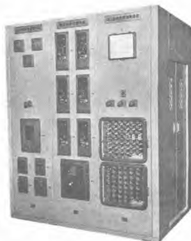
笠寺変電所遠隔制御装置盤 (被制御)。
