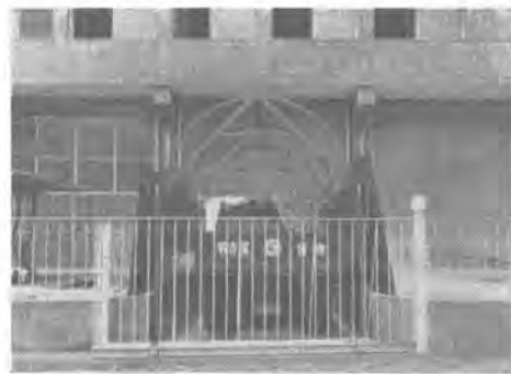
電々公社（名古屋）10t 貨物自動車用エレベータ Large capacity Side-Walk elevator for Truck transportation (10 ton) Telephone-Telegram corp., Nagoya.
