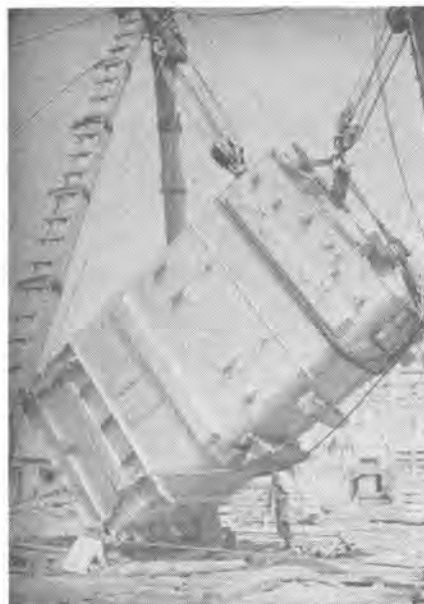
現場組立中の国鉄新鶴見変電所納 3 相 147 kV、33,000 kVA 変圧器 33,000 kVA 3 phase 3 wdg transformer 147/60/13 kV, 50 c/s Form-fit type.
