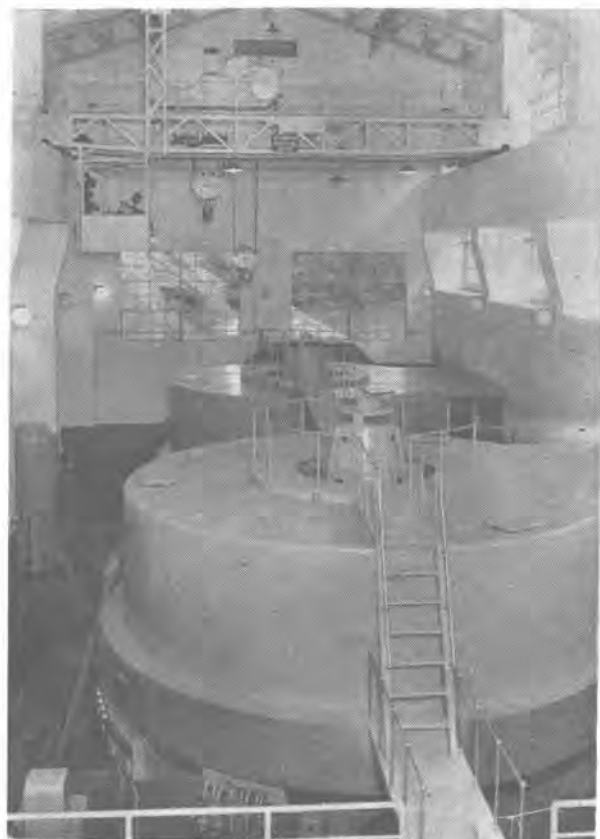
中部電力久瀬発電所 10,000 kVA 傘型水車発電機 10,000 kVA, 11 kV, 240 rpm, umbrella type water turbine generator.
