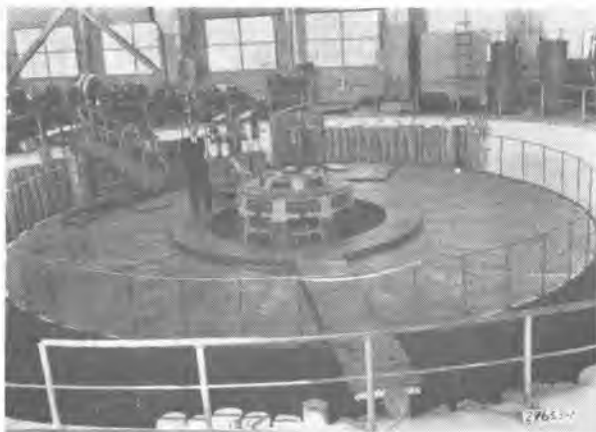
関西電力椿原発電所 45,000 kVA 傘型水車発電機
