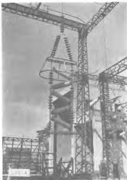
丸山発電所向 140 kV 級 SV-W 型避雷器 Type SV-W lightning arrester 140 kV.
