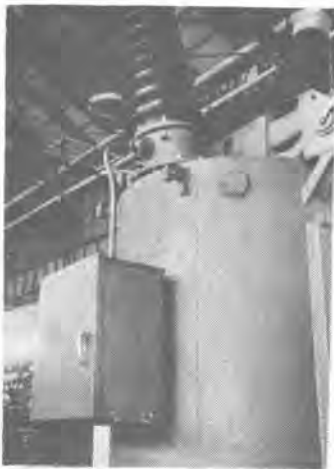
PBA 套管分圧器を取付けたところ Type PBA potential device.
