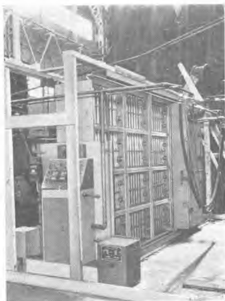
5 図 自動洗浄型電気式空気清浄装置(空気流入側)
