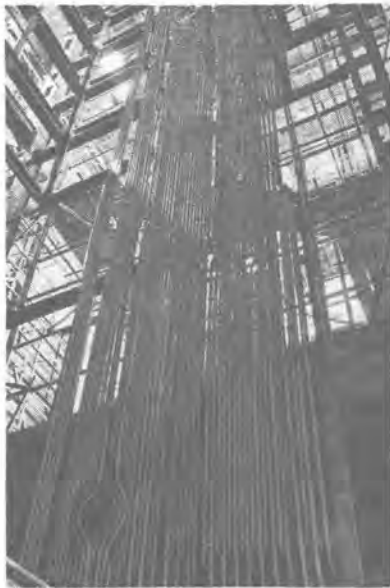
2 図 据付中の汽罐（炉壁冷却管を示す） Fig. 2. Boiler under installation.
