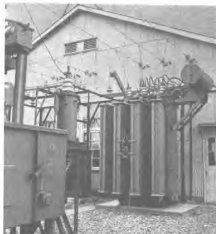
15 図 1000 kW イグナイトロン用変圧器
