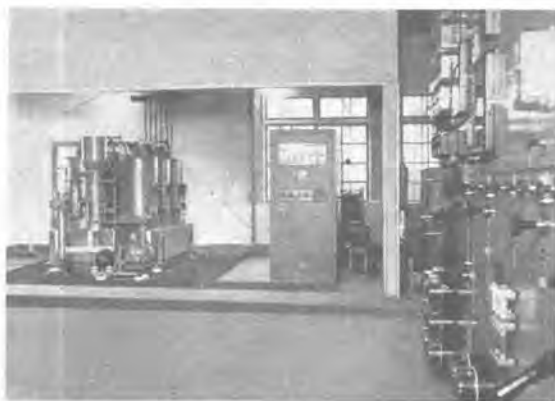
12 図 富士山麓電気鉄道株式会社 富士吉田変電所納 1000 kW 1500 V 6タンク 重負荷公称定格風 冷式鉄製イグナイトロン整流器、本体ならびに 制御器具盤配置状況
