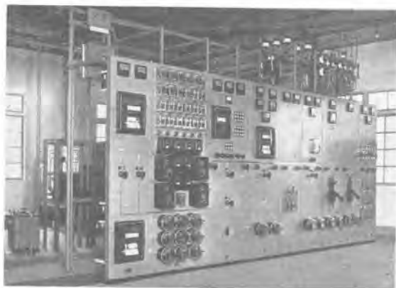
13 図 富士山麓電気鉄道株式会社 富士吉田変電所納 受電盤ならびにリレー盤全景
