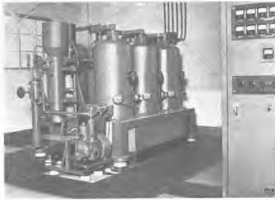
1 図 1000 kW 1500 V 6 タンク風冷式イグナイトロン整流器重負荷公称定格 Fig. 1. A 6 tank unit of air cooled, pumped type ignitron rectifier in 1000 kW ratings, 1500 V DC.
