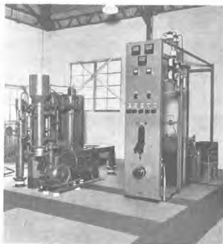
14 図 1000 kW 1500 V 6 タンク風冷式イグナイト ロン整流器、予備タンク装置ならびに化成装置
